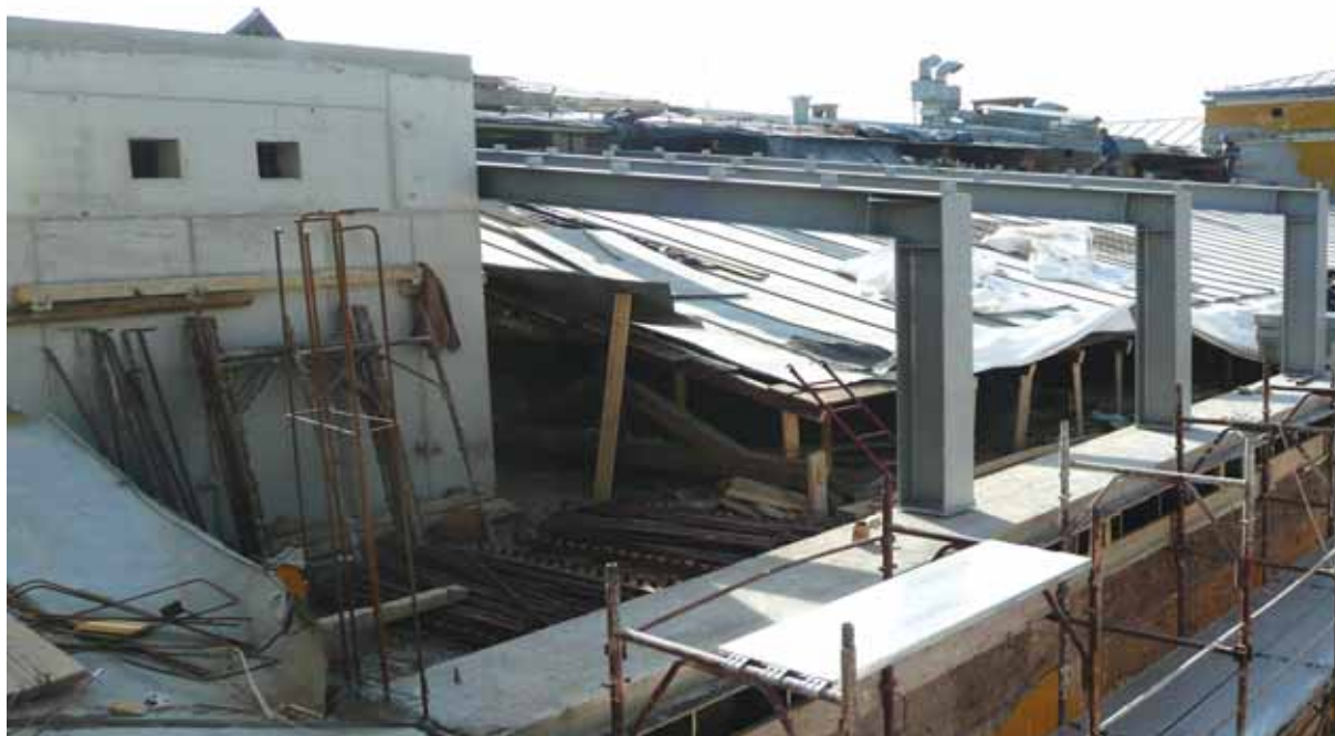
Слика 10.1.: Реконструкција зграде Општинског и Кантоналног суда у Сарајеву
