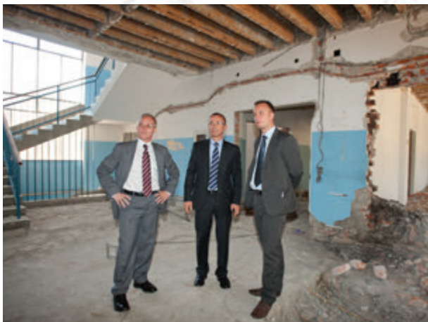
Zgrada Osnovnog suda u Modriči prije rekonstrukcije
