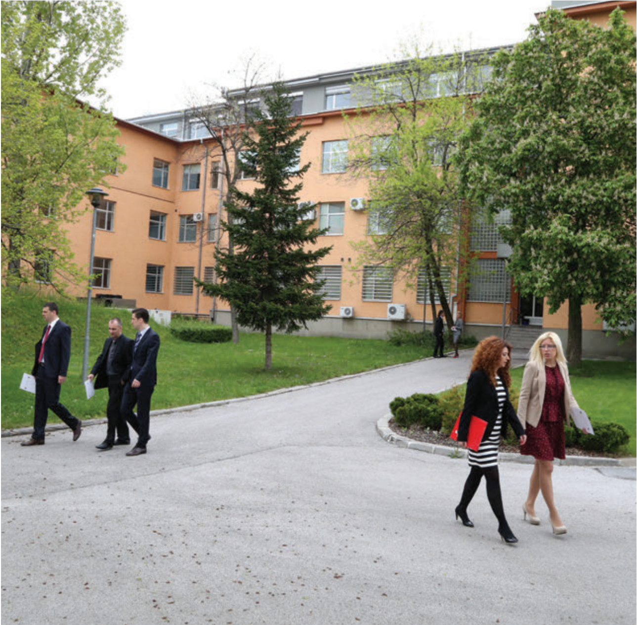
Zgrada Suda i Tužilaštva Bosne i Hercegovine
