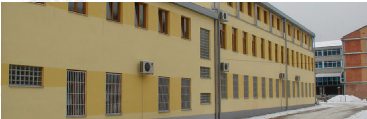
Savremena zgrada prilagođena potrebama građana, nakon rekonstrukcije
