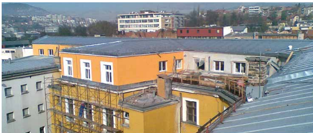
Slika 10.5. Podizanjem krova na sjevernom krilu zgrade izgrađeno je 12 novih ureda
