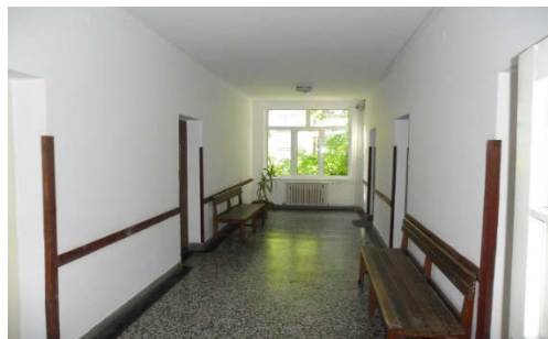
Slika 10: Izvršeni molerski radovi u hodniku suda
